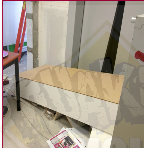
Elevator Door Askew
